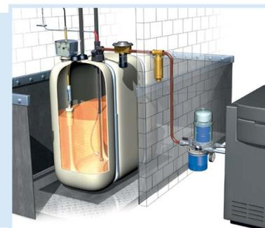
„PROOFED BARRIER“ bei Montage mit Entlüftungsschlauch.
